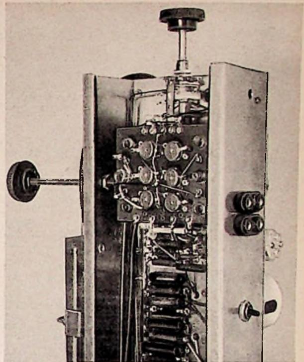
Teilansicht der Verdrahtung mit Spulenaggregat und Wellenschalter
